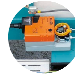
Zuluftklappe mit Stellmotor
